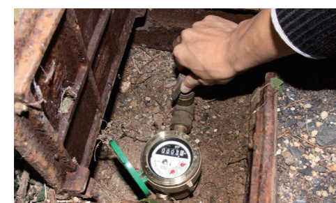
もし破裂したら、水道管のバルブをしっかりと閉めましょう
