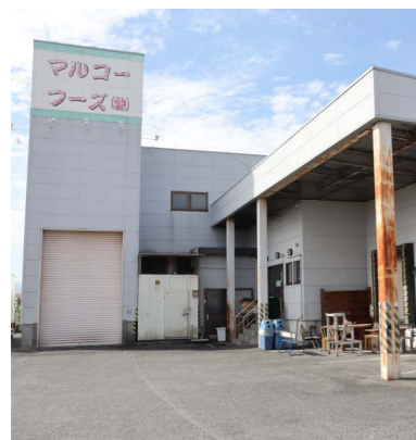
同社の解体処理加工施設
