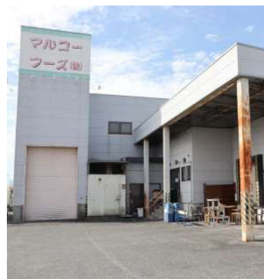
同社の解体処理加工施設
