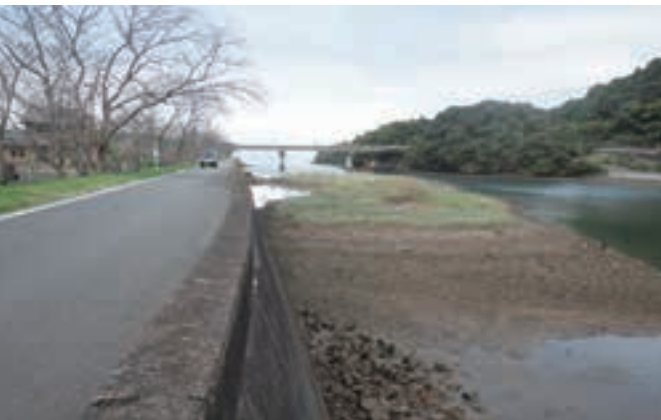
土砂撤去を望む津奈木川河口
