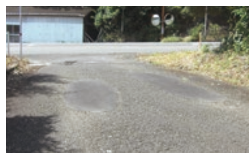
町道日野越線の凹凸ヶ所を補修
