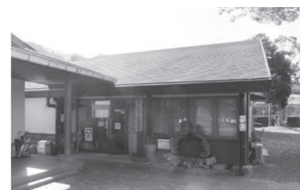
改修が予定されている津奈木町図書館。児童クラブとして利用されていたスペースが新しく図書スペースとなる予定です。
