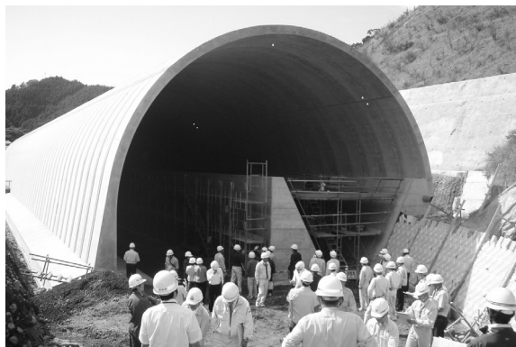
▲現場見学し、施工状況を確認しました
